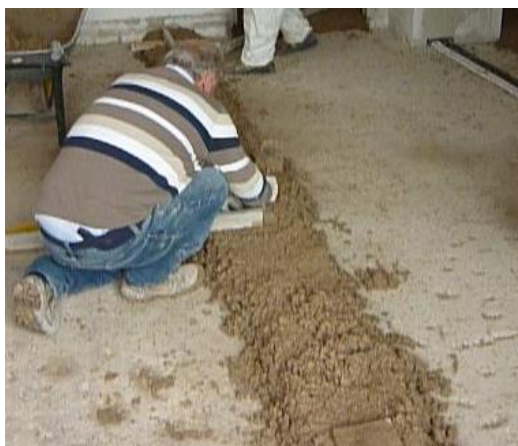
FOTO B – POSA IN OPERA SU SOLAIO
