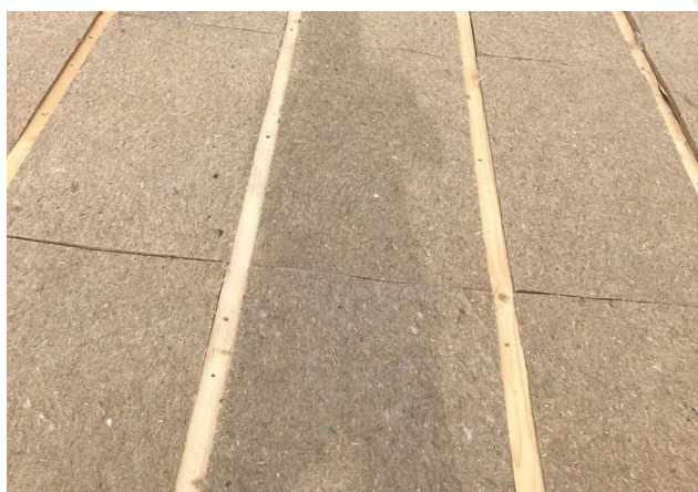
FOTO B: Applicazione isolamento tetto
