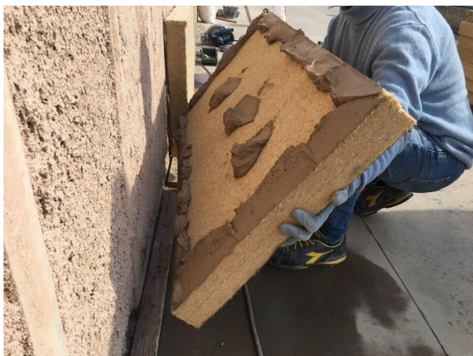
Fissaggio CANAPANNEL 100 con CANAPACOLL su supporto
