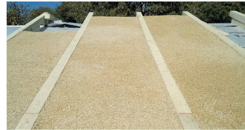
CANAPAMAS 385 kg/mc による屋根の断熱
