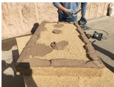
Posa CANAPACOLL con sistema di cordolo e 3 punti centrali
