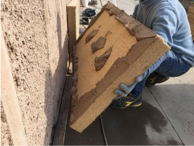
Fissaggio CANAPANNEL 100 con CANAPACOLL su supporto
