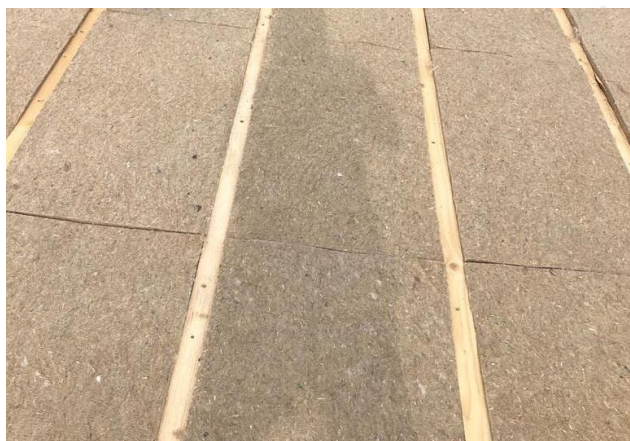
FOTO B: Applicazione isolamento tetto
