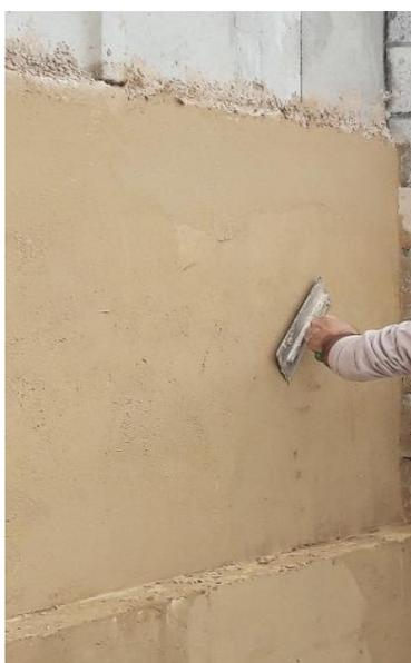
FOTO B: Passaggio di frattazzo su stucco esterno termoisolante CANAPASTUCK.
