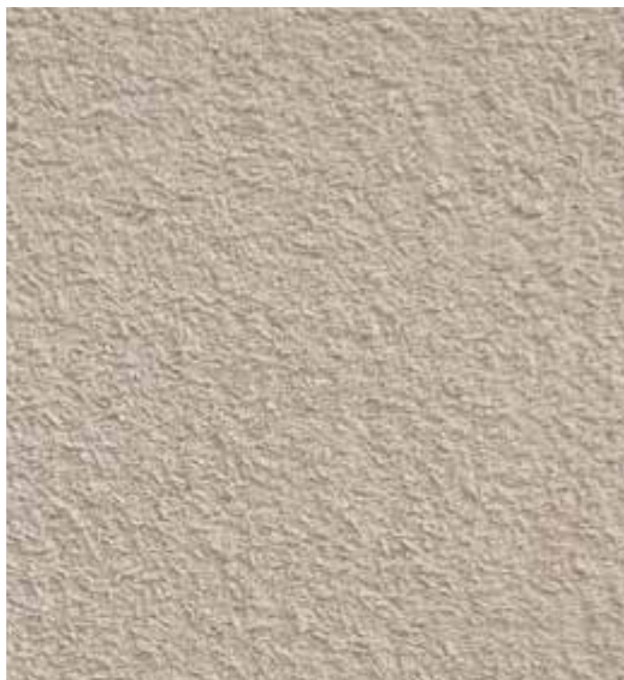
Particolare finitura CANAPAMIX 2 intonaco termoacustico
