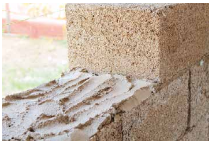
Utilizzo di CANAPAMALTA con CANAPLOCK
