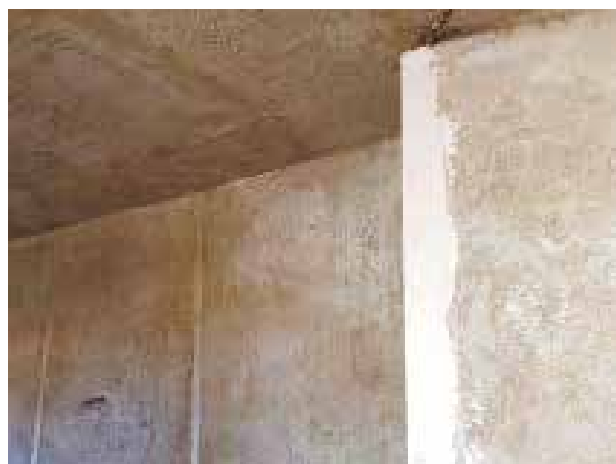
Intonaco interno con CANAPAMIX 2
