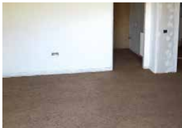
Massetto solaio con CANAPAMAS 385 kg/mc
