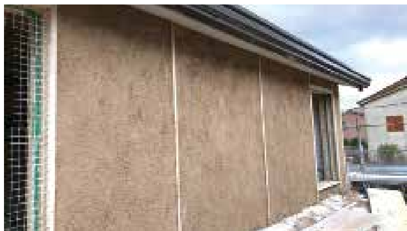
Intonaco a spessore realizzato su parete in legno con CANAPAMIX 2
