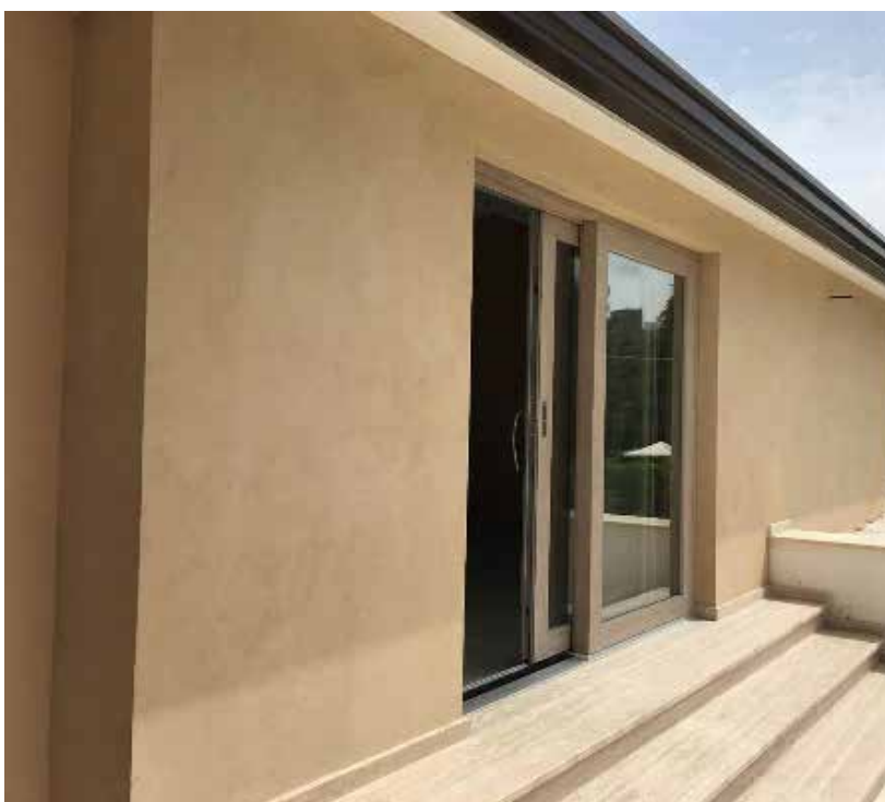
Rasatura esterna con CANAPASTUCK al naturale
