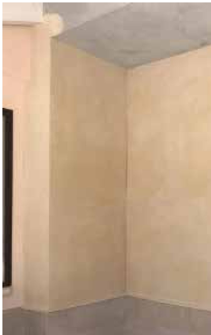
Rasatura con CANAPASTUCK al naturale
