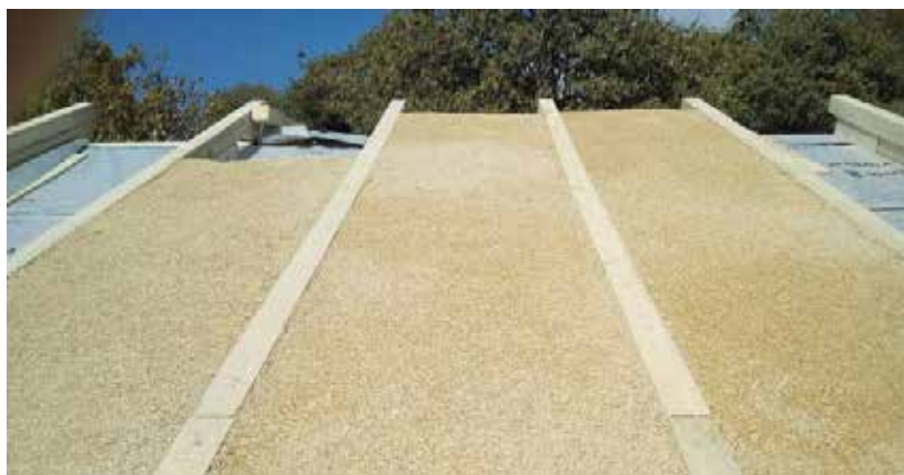
Massetto per isolamento tetto con CANAPAMAS 385 kg/mc
