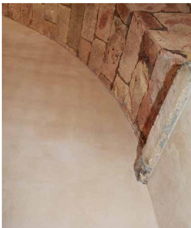
Rasatura interna con CANAPASTUCK al naturale
