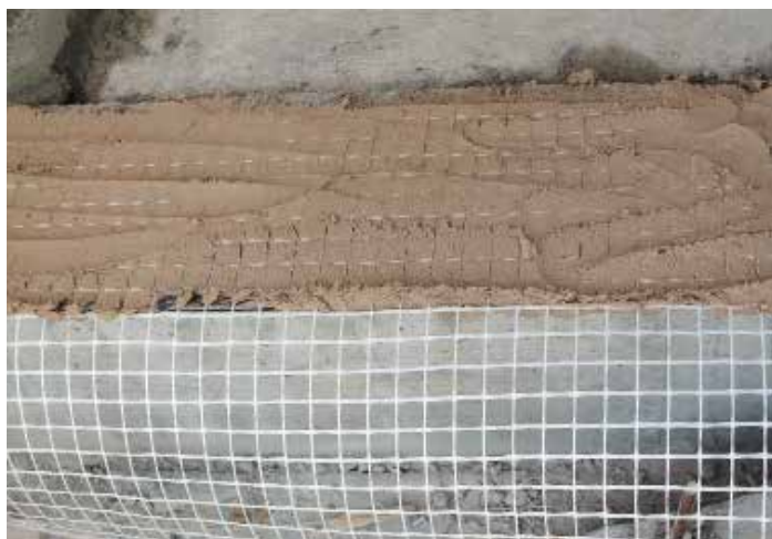
Malta di allettamento blocchi con rete (posa da terra)
